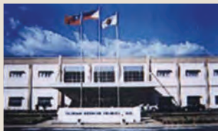
Hitachi Air Conditioning, Филиппины
