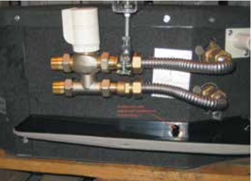
Поддон для сбора конденсата (внешний) и запорно-регулирующий узел смонтированы на кассетном фанкойле.
