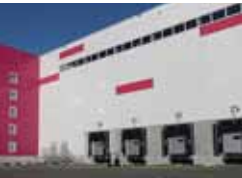
Распределительный центр Wildberries г. о. Подольск, МО
